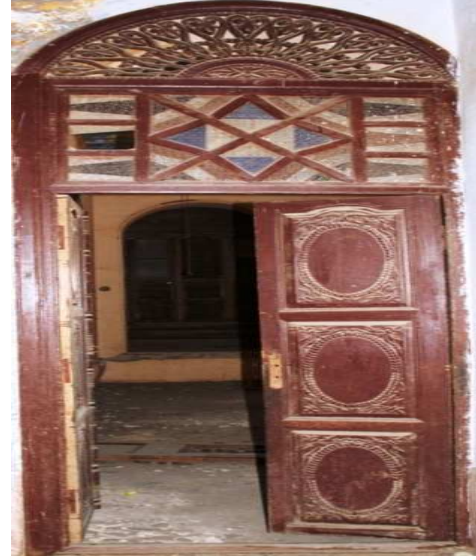
لوحة (١٨) نموذج لأحد أبواب حجرات الطابق الأول ببيت الكاتب، ويلاحظ طريقة تصميم القسم العلوي (المنور).
