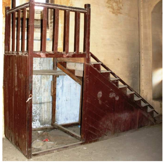
لوحة (٢٦) السلم الخشبي المتحرك الصاعد إلى المقعد العلوي ببيت الكاتب، والمؤدي بدوره إلى السقف العلوي.
